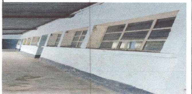
Foto 4: SUSTITUCIÓN DE ESTRUCTURA DE METAL DE VENTANA 11 M2
