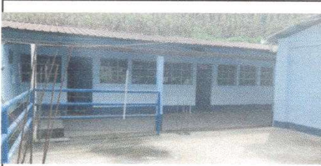
Foto1: PINTURA EN MUROS EXTERIORES E INTERIORES, 400 m2.
