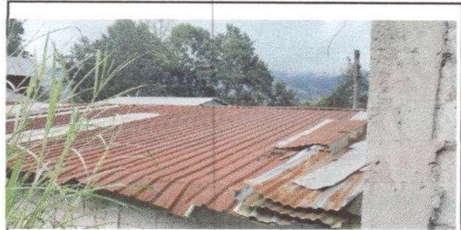
Foto 2: SUSTITUCION DE LAMINA POR LAMINA TROQUELADA ALUZINC, CALIBRE 26. UN TOTAL DE 209 M2
