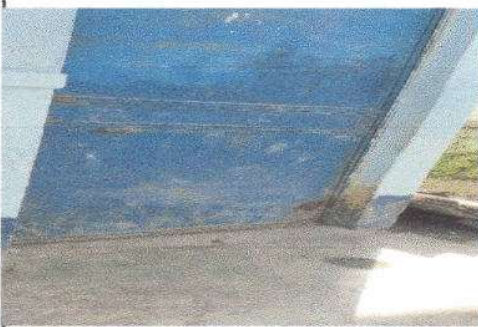
Foto 3: MANTENIMIENTO A ESTRUCTURAS (LIJADO, SUGECIONES, Y APLICACIÓN DE PINTURA) 4
